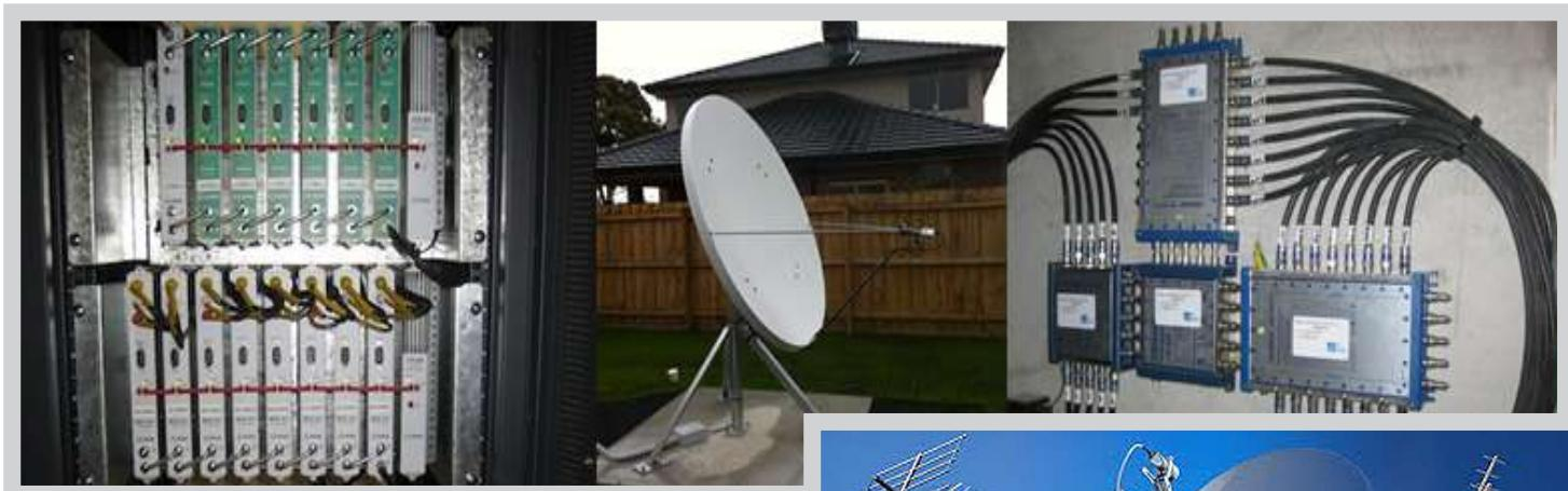
SMATV Sistemleri, büyük ve orta ölçekli projelerde, müşteri tarafından istenilen yerle ve yabancı kanalların uydu üzerinden alınmasını, ilgili mahallere dağıtılmmasını sağlar. Sistem, TV priz sayısının çok olduğu mekânlarda çok etektiftir ve maliyeti diğer TV yayını izlenen sistemlere göre daha düşüktür. Ayrıca SMATV sistemleri, kablolu TV ve dijital TV dağıtıcı sistemleri ile birlikte de çalışabilir.
